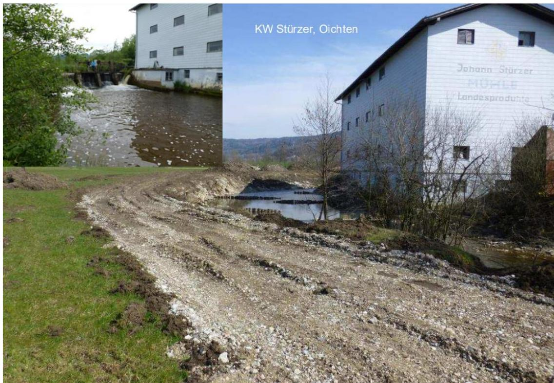
Abb. 21 Vorher-Nachher-Bild der entfernten Wehranlage des „KW Stürzer“.
