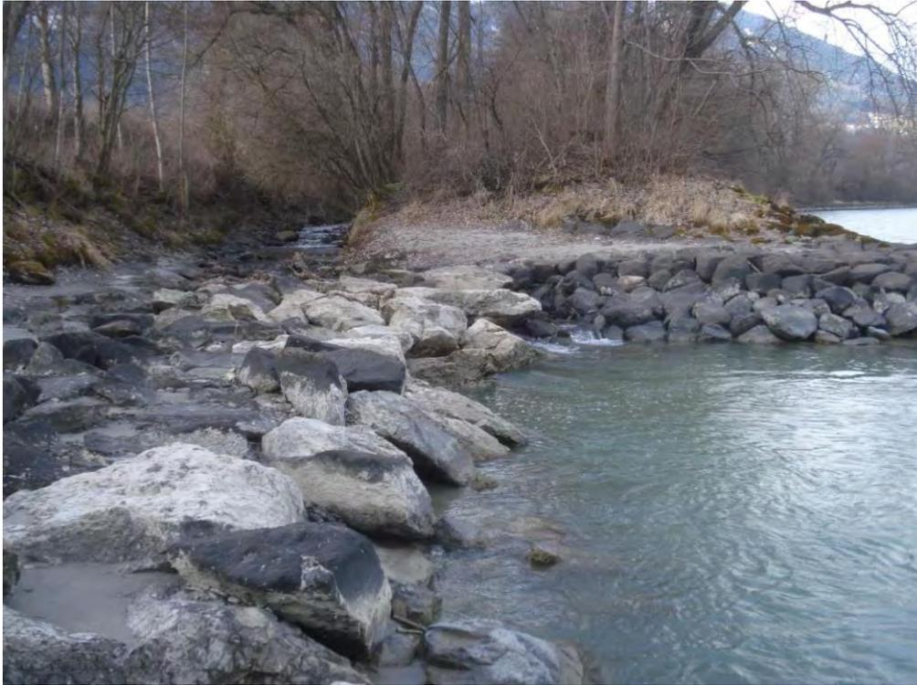
Abb. 26 Ufersicherung im Inn unmittelbar an der Gießenbachmündung.
