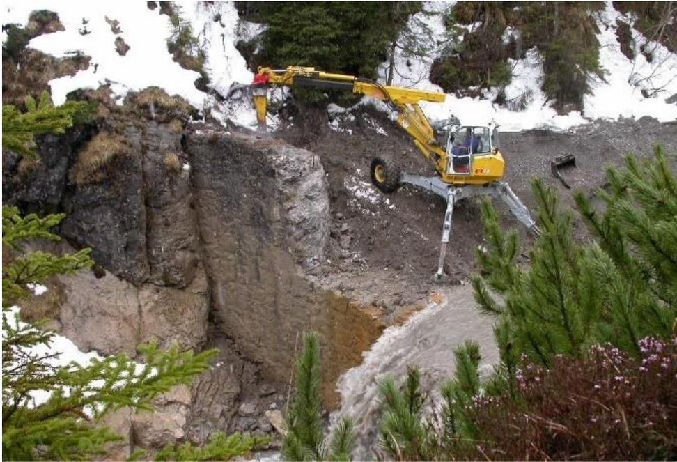
Abb. 23 Phase eins des Rückbaues der äußeren Hornbachsperre im Jahr 2003: Absenkung um 3m.
