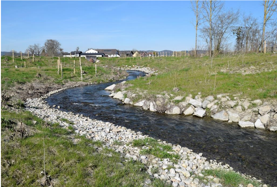
Abb. 10 Überfallfreie Fischaufstiegshilfe in Form eines asymmetrischen Raugerinnes am Puppinger Wehr (Foto: ezb-Zauner GmbH)
