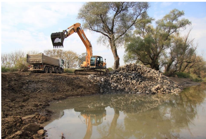
Abbildung 6: Entfernung eines Leitwerkes im Rahmen des bereits umgesetzten Projektes LIFE+ Untere March-Auen, Uferrückbau Einlaufbereich Lange Luss © Copyright RIOCOM/ Roither
